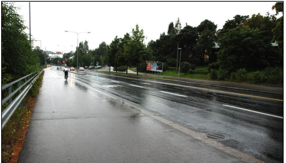
Kuva 11. Pispalan valtatie asfalttipäällysteisen katualueen leveys on monin paikoin noin 16 metriä. Katualueella muodostuu paljon hulevesiä. 10
